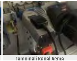
Jumping'li Kanal Açma
